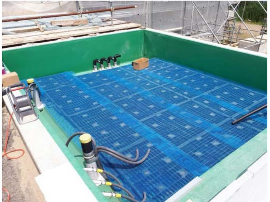
▲ Das Filtersystem funktioniert mit selbstentwickelten Filterpaletten, welche eine sehr gleichmäßige Durchströmung garantieren, einen absaugbaren Hohlraum bilden und blowerfähig sind.
