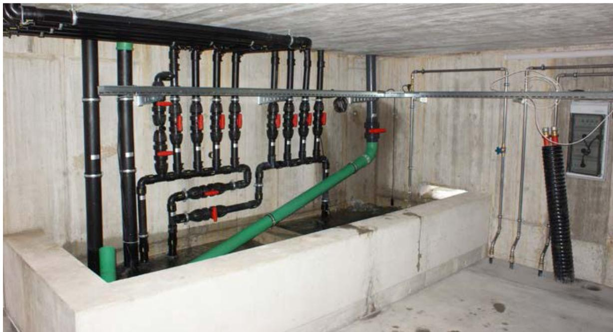
▲ Das zweigeteilte Rückhalte- bzw. Ausgleichsbecken mit je einer Pumpe erhöhte die technischen Anforderungen. Dafür bot ein großzügiger Technikraum unterhalb des Schwimmbeckens ausreichend Platz.
