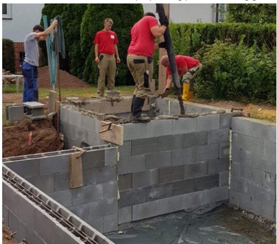
▼ dann mit der Betonpumpe im Nu gefüllt und der Boden gegossen.
