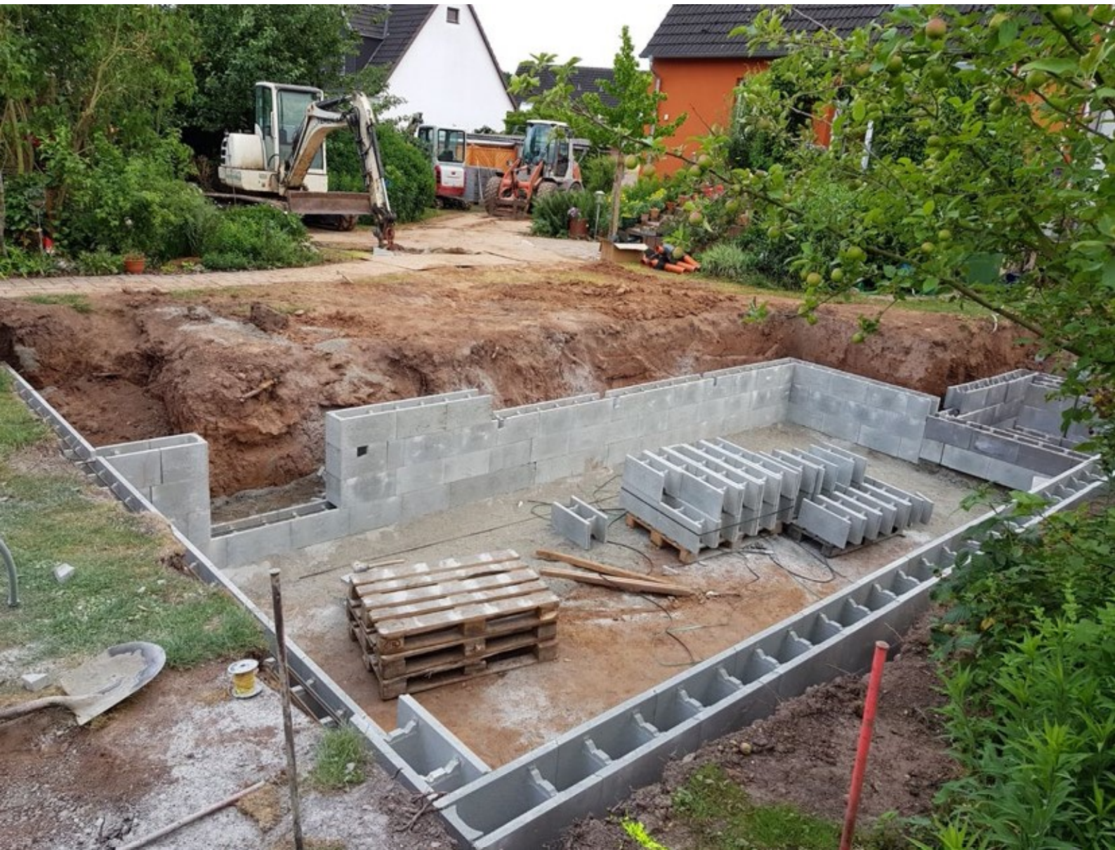
▲ Erst werden die Wände aufgebaut,
