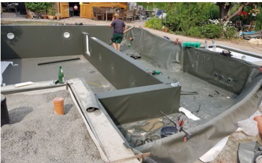
▲ Die Folienfarbe bestimmt, wie das Wasser später schimmert und die Arbeit des Folienmanns, ob der Pool am Ende dicht ist und das auch über eine lange Zeit bleibt.
